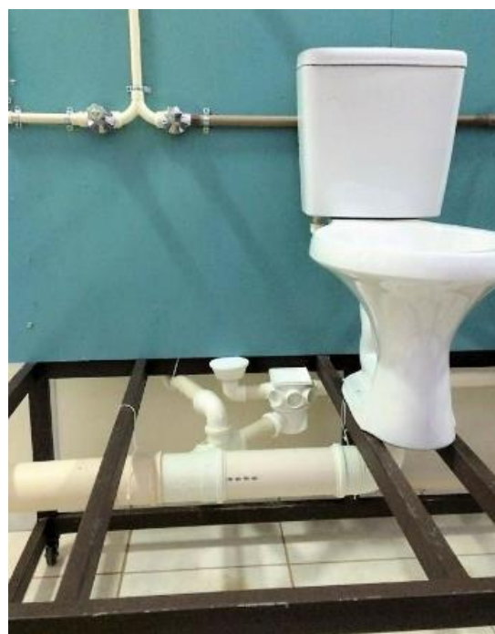
Figura 5 – Fixação das tubulações de esgoto cloacal.
