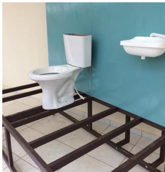
Figura 3 – Posicionamento dos aparelhos sanitários.
