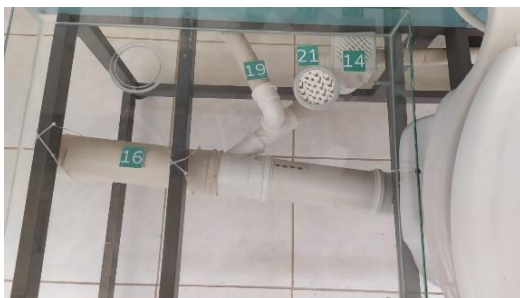
Figura 15 – Instalações de esgoto cloacal.
