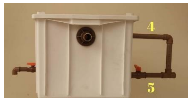
Figura 8 – Vista posterior do reservatório. Os números 4 e 5 representam o extravasor e a tubulação de limpeza do reservatório, respectivamente.
