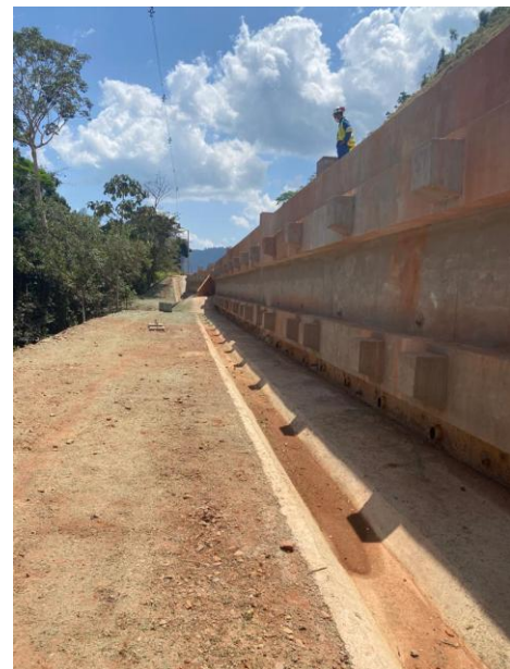
Figura 16 – Muro de contenção concluído, Pará, Brasil. 2020.
