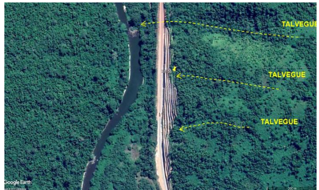
Figura 3 – Canais de drenagem superficiais. Pará, Brasil. 2020.
