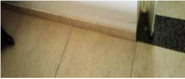
Figura 3 – Fissura na parede entre o banheiro e o quarto, a patologia está “paralela ao piso.
