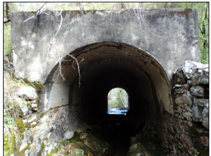
Figura 12 – Boca de entrada (montante) do bueiro ogival próximo ao distrito de Conselheiro Mata.
