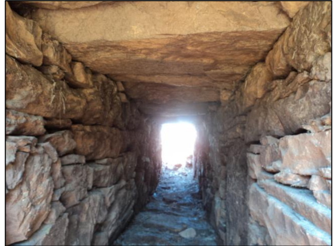
Figura 5 – Travessia do tipo bueiro de greide celular simples em alvenaria de pedra seca.
