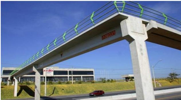
Figura 10 – Passarela em seção T. (PRECON, 2021).
