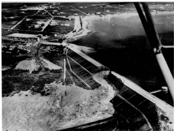
Figura 22 – Rompimento da barragem da Pampulha 1954 (Metro Jornal, 2019).
