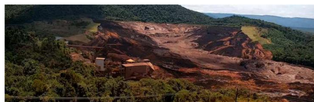
Figura 25 – Barragem I após o rompimento (Robertson et al., 2019).
