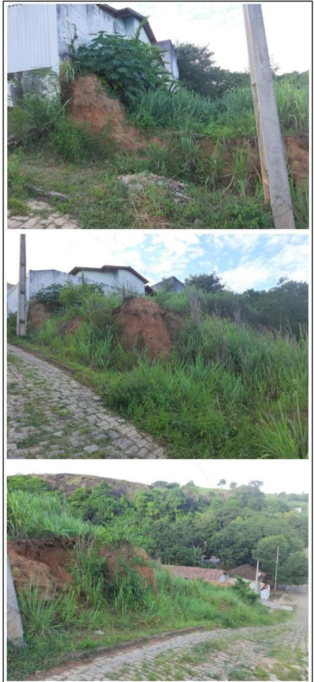
Figura 7 – Imóvel localizado sob talude em processo erosivo.
