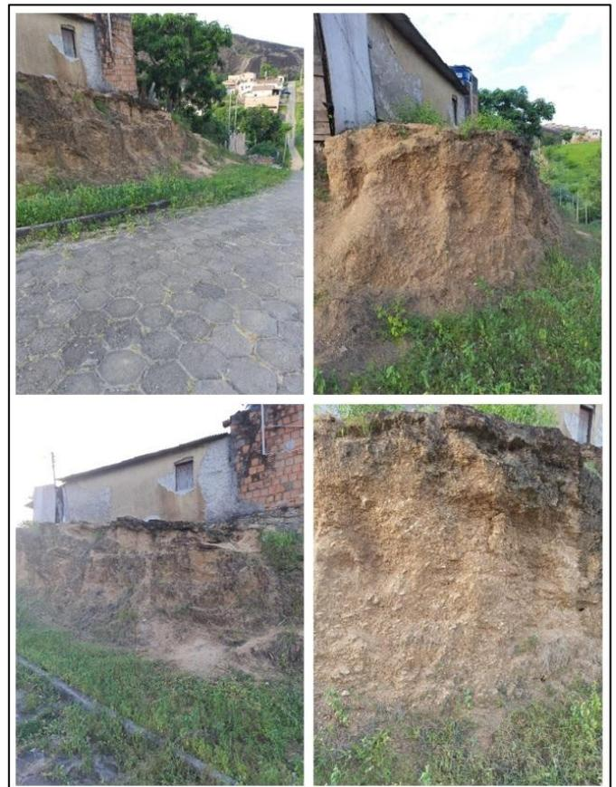
Figura4 – Imóvel localizado em talude com processos erosivos.
