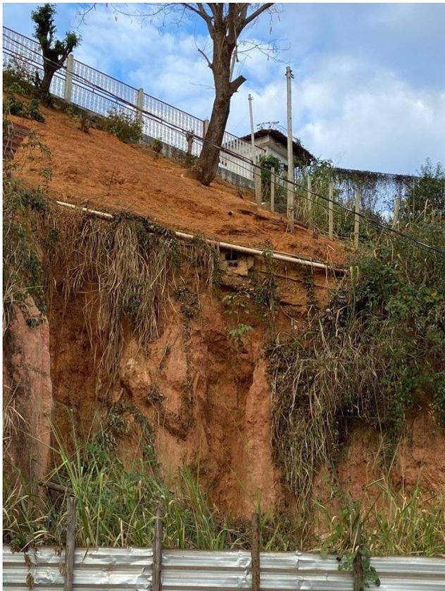
Figura 5 – Talude com significativas evidências de instabilidade e edificação ao topo.
