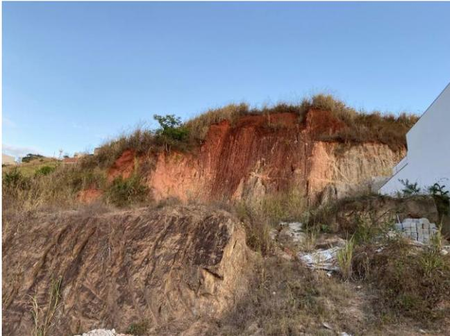
Figura 5 – Talude com indícios de instabilidade.
