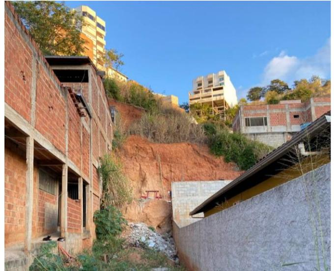
Figura 7 – Degraus e tricas no talude.
