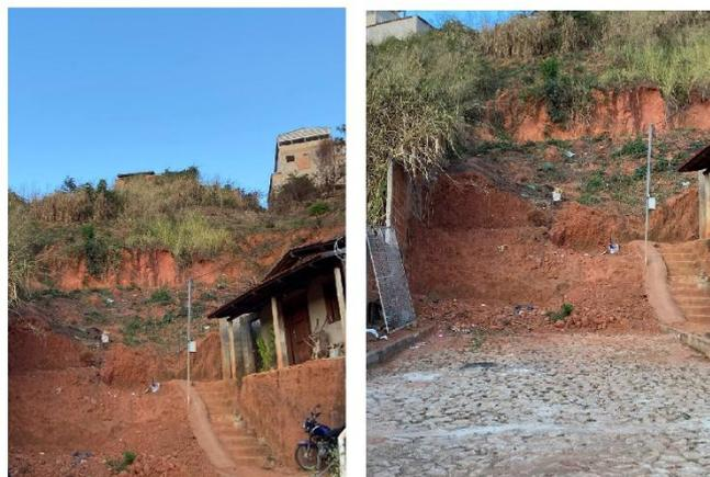
Figura 4 – Talude com interferências Antrópicas.
