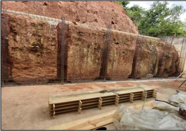
Figura 4 – Edificação 124: contenção após deslizamento.
