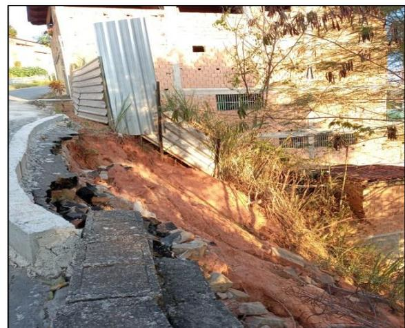
Figura 7 – Blocos de concreto delimitando o entorno da Rua Riccioti Míglio atingida por deslizamento de massa de solo (Ponto 2).
