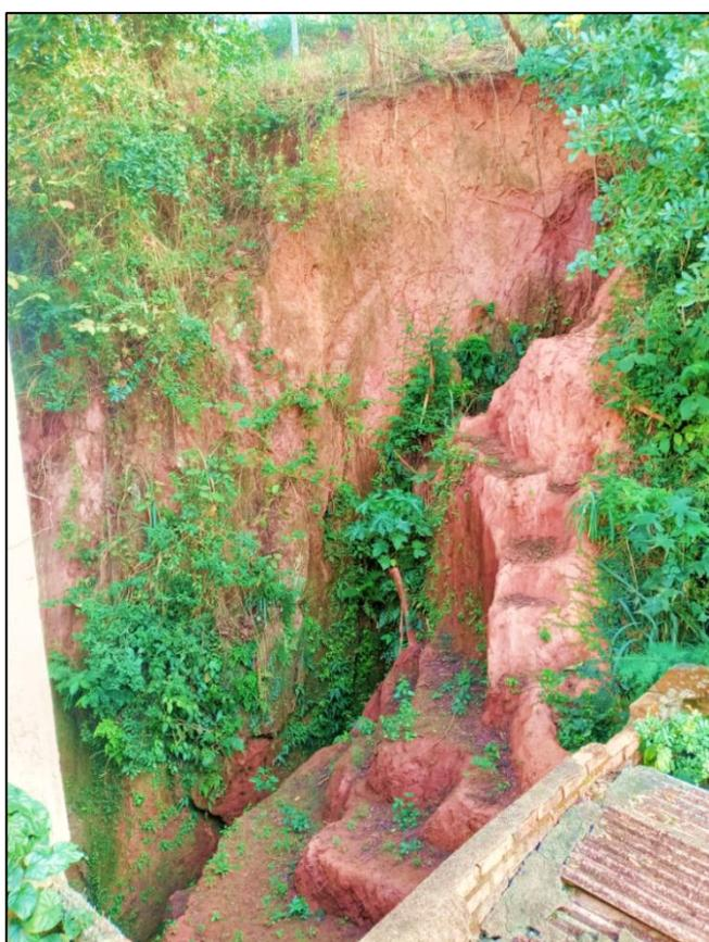
Figura 8 – Deslizamento do talude em corte na Rua Minervino de Castro Pinto (Ponto 3).
