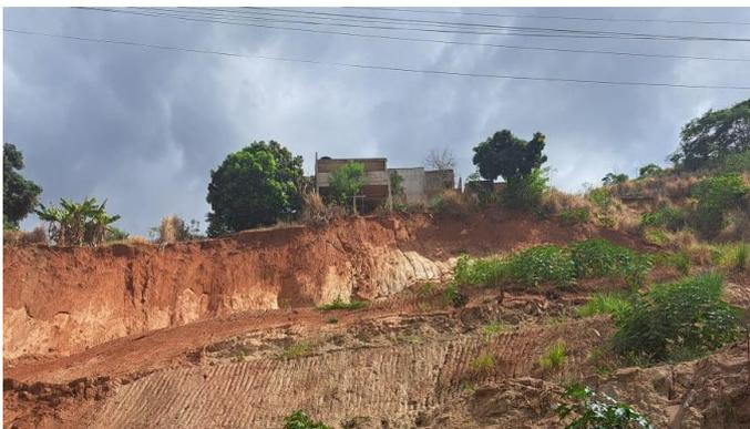
Figura 12 – Talude com pouca cobertura vegetal.
