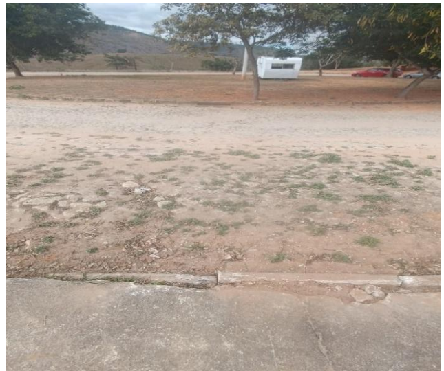
Figura 15 – Área permeável na rotatória.
