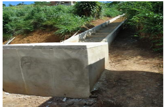
Figura 10 - Exemplo de escadaria de drenagem.
