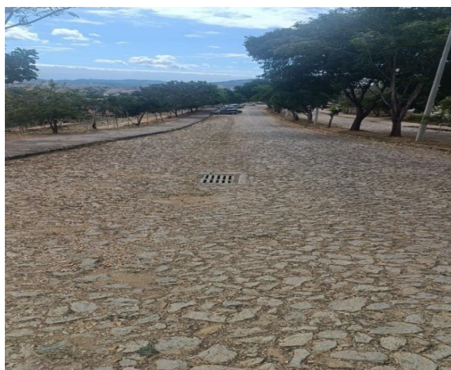
Figura 23 – Boca de lobo no meio da via.
