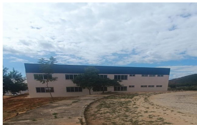
Figura 17 – Laboratório das engenharias.
