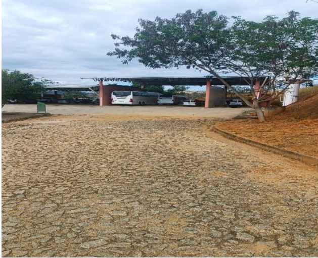
Figura 25 – Prédio do transporte.
