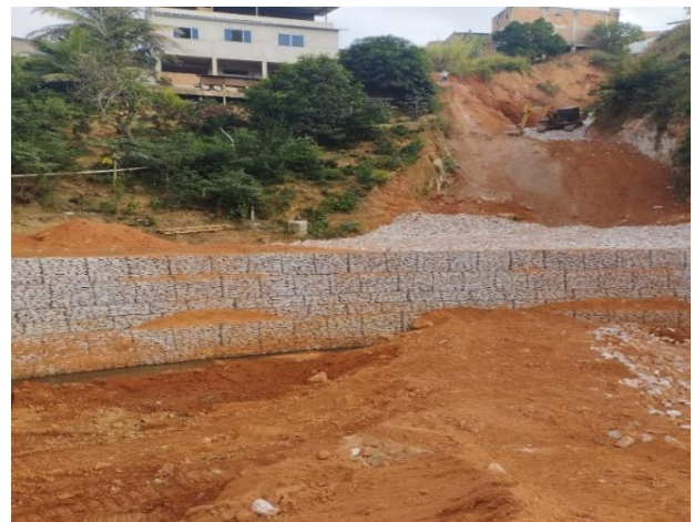
Figura 11 – Exemplo do muro de gabião.
