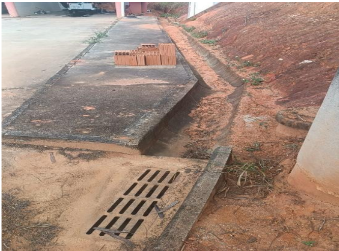
Figura 26 – Canaleta obstruída.
