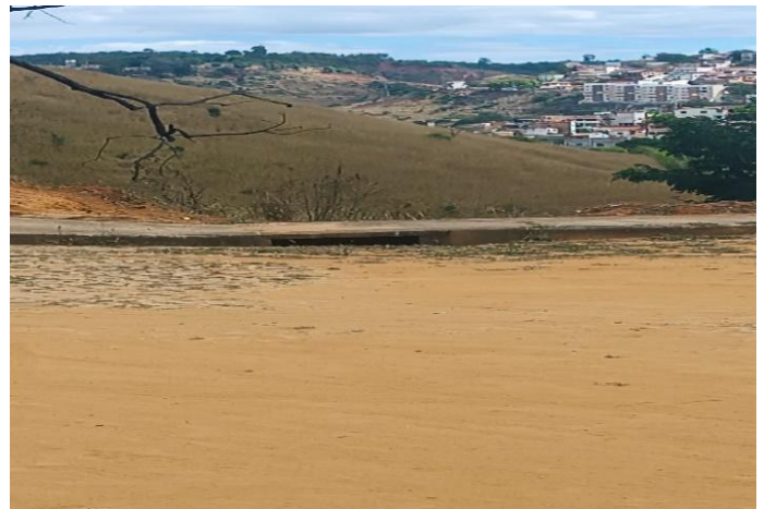
Figura 8 – Boca de lobo em local inadequado.
