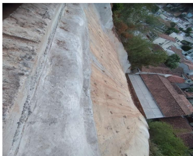
Figura 4 – Talude Argamassado.
