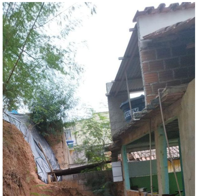
Figura 7 - Talude com Lona preta
