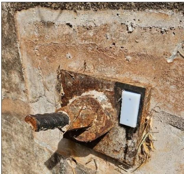
Figura 8 – Tirante com início de corrosão.
