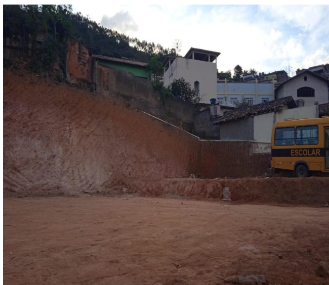
Figura 3 – Ponto C: Rua Francisco de Souza Ferreira, nº 253 (prox.), coordenadas 18°13'49.37"S, 42°50'28.25"O.
