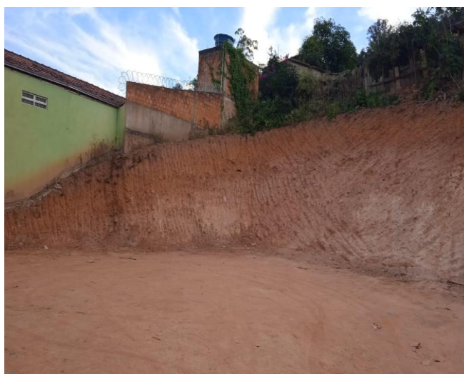
Figura 4 – Ponto C: Rua Francisco de Souza Ferreira, nº 253 (prox.), coordenadas 18°13'49.37"S, 42°50'28.25"O.
