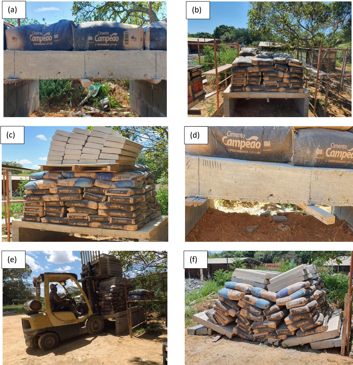
Figura 6 – Representação do ensaio de carga a) Início da aplicação do carregamento; b) Laje pré-moldada carregada com 1000 kg/m 2 na etapa 6; c) Deslocamento visível após carga de 1000 kg/m 2 ; d) Estrutura carregada com 1892 kg/m 2 na etapa 9 e) Momento de ruptura da estrutura; f) ELU- Ruptura da laje após etapa 10 de carregamento.
