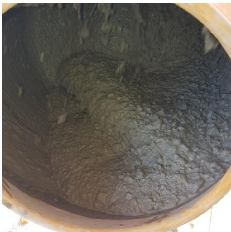
Figura 14 – Concreto sendo processado
