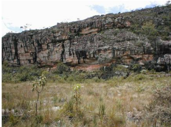
Figura 02. Vista geral do paredão da “Sentinela”
