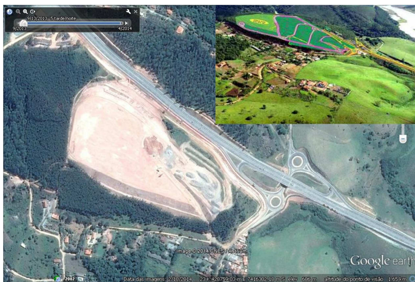
Figura 6: Polo Industrial de Paraibuna – Acima à direita figura ilustrativa do projeto, a figura maior mostra a área já com terraplanagem. Fonte: Prefeitura Municipal de Paraibuna (2013) e Google Earth (2014). Adaptado pelo autor.
