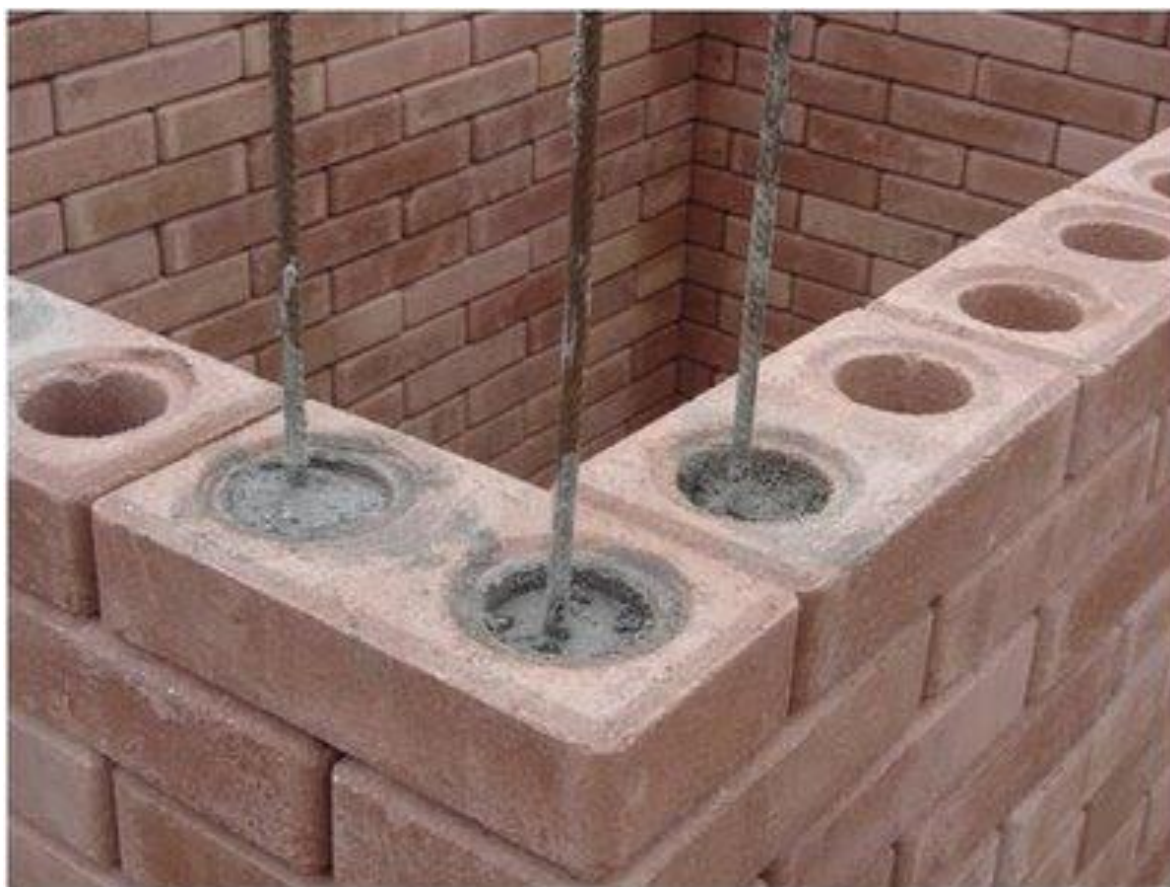
Figura 1- Paredes de tijolos ecológicos
