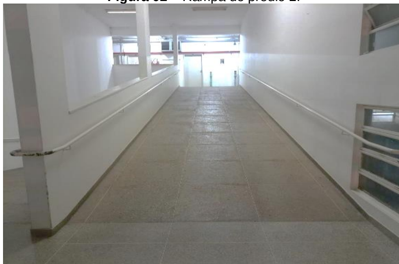
Figura 02 – Rampa do prédio 2.
