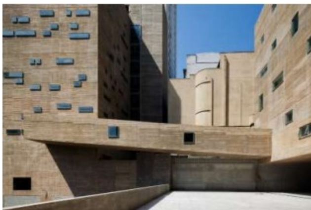
Figura 1 – Concreto com pigmento marrom no Complexo Praça das Artes
