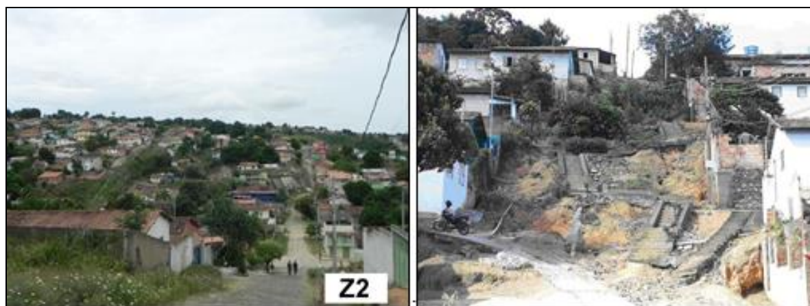
Figura 10. Encosta do bairro Alziro Zarur com escadarias apoiadas em solo com focos erosivos.
