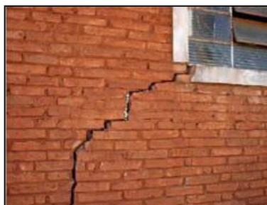
Figura 2: Ocorrência de trinca e fissura na edificação causada por colapso de solo
