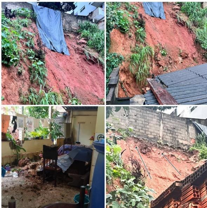
Figura 5: Deslizamento do Talude
